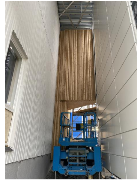
Betonielementtiä, puurima- sekä peltikasettijulkisivua harmoniassa
