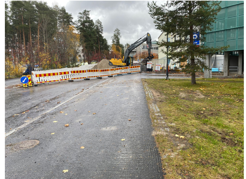
Viimeinen kaivanto etenee. Sadevesien poisjohtamisen ja vesijohton äärellä ollaan
