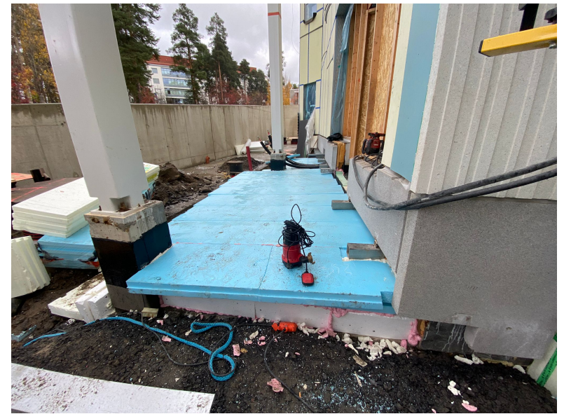
Sisäänkäynnin edusta työn alla Kaupunginsairaalan kulkutien puoleisessa päädyssä
