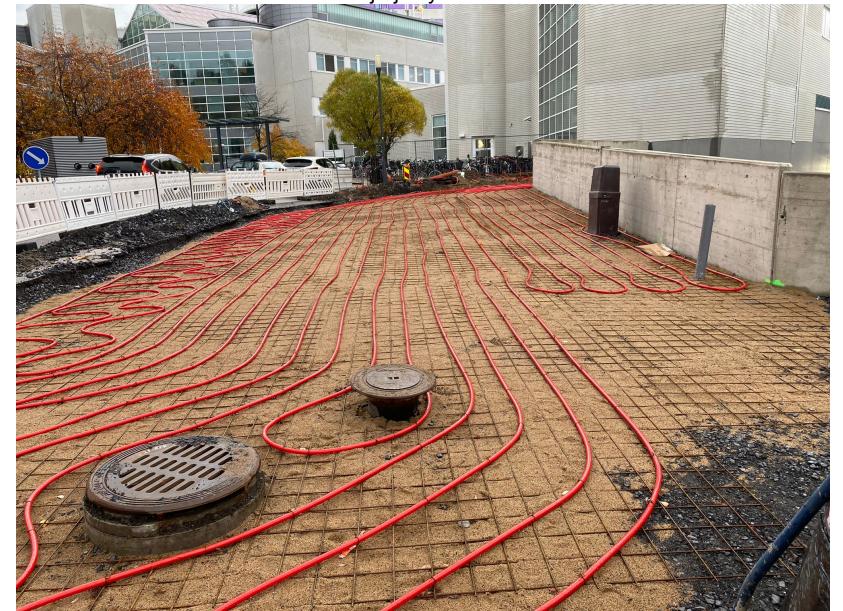
Liukkauden torjuntaa integroituna rakenteeseen
